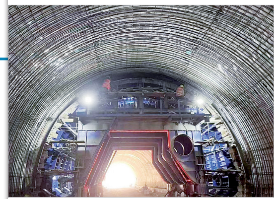
310国道杨家山隧道
