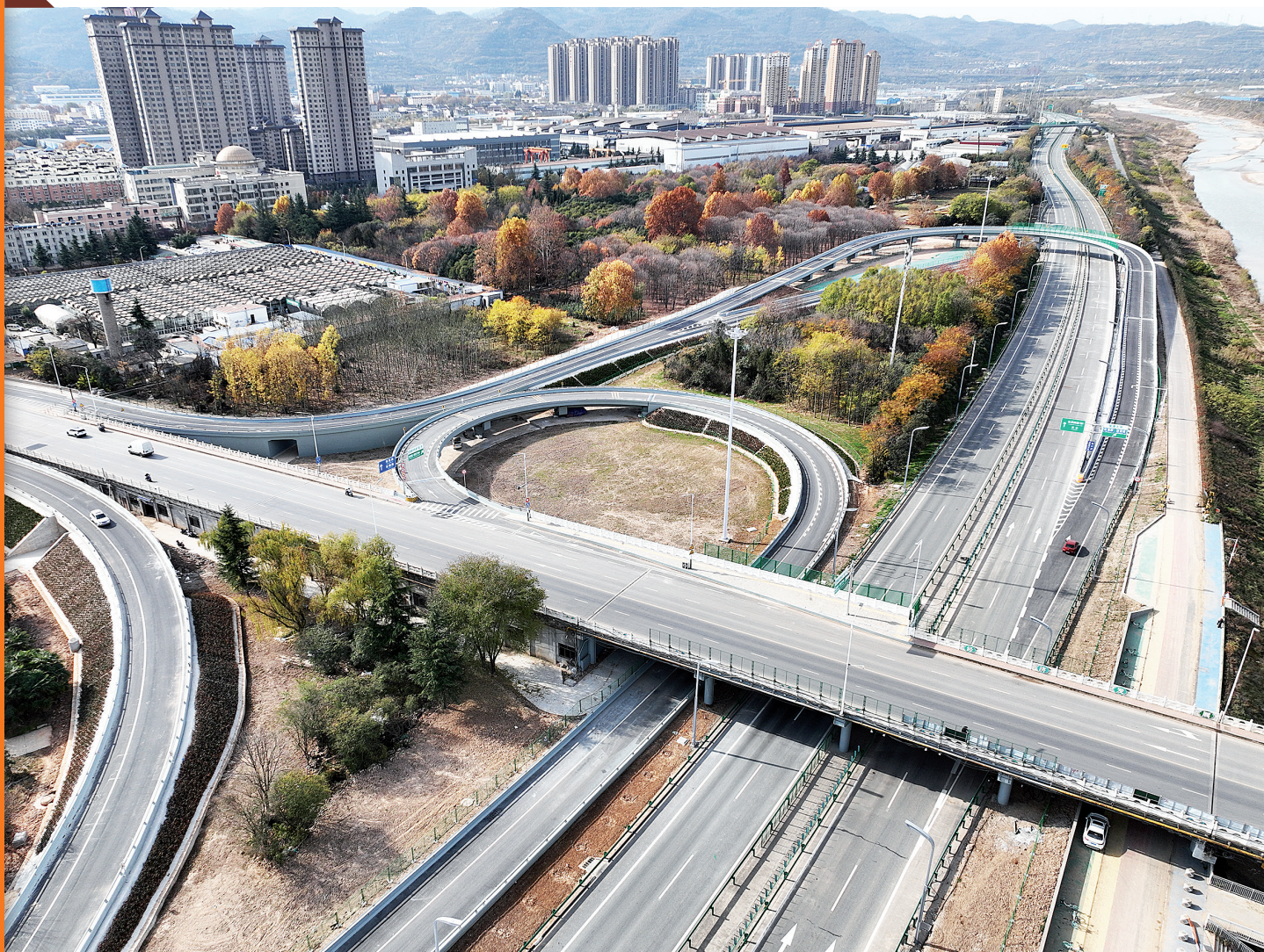
连霍高速宝鸡城区段市政化改造工程福谭片区立交桥 谢克强摄
