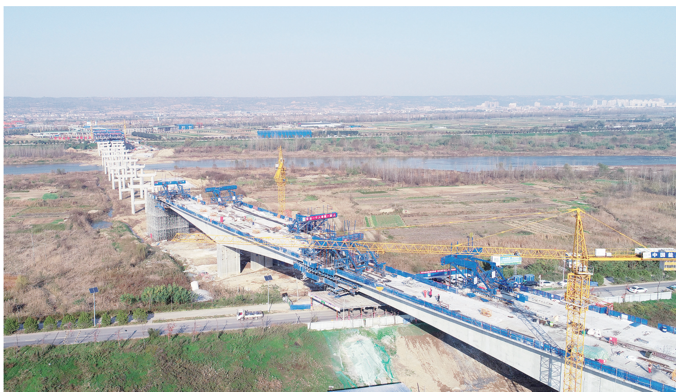
施工人员在关环高速渭河特大桥建设现场加紧施工
