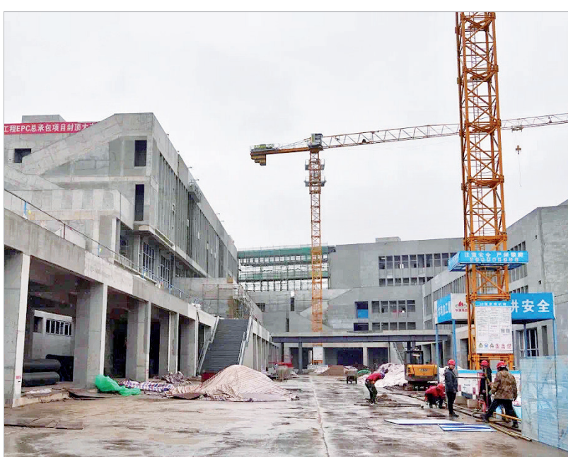
渭滨区第一初级中学项目建设现场
