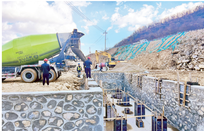
在太白县龙王河水库项目现场，工人进行拌和站基础施工。
