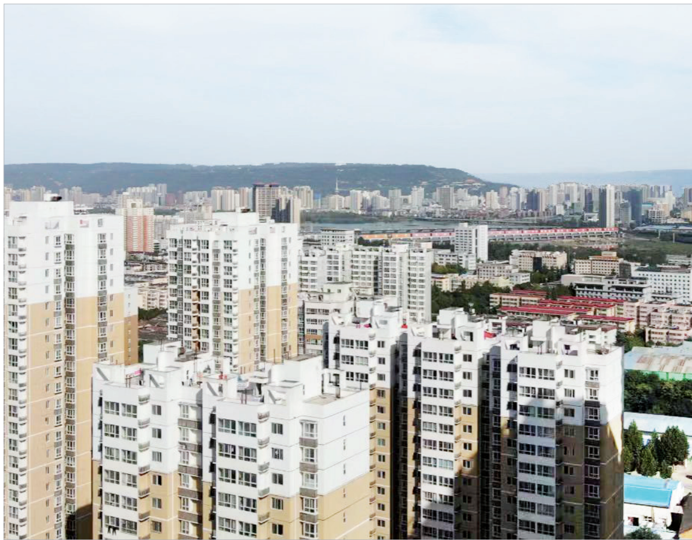
龙山雅居保障性住房小区航拍图
