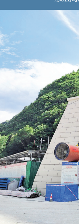
鸚鵡隧道贯通
