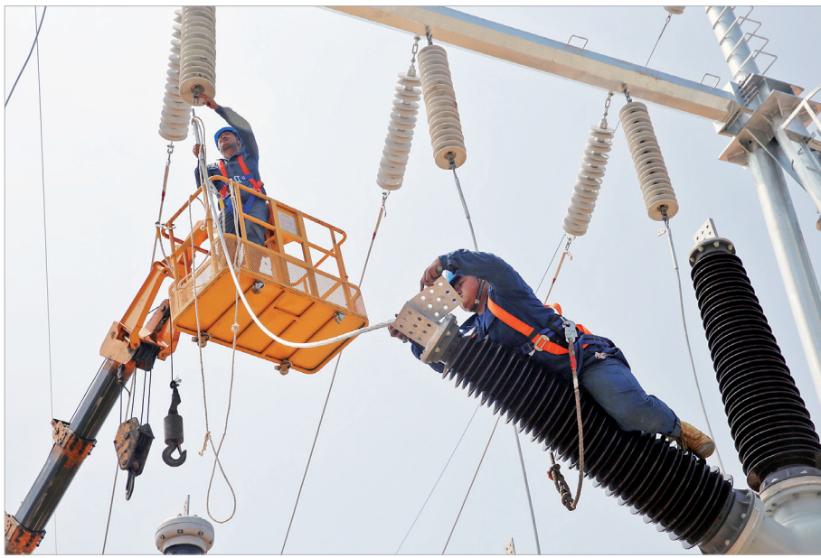
施工人员检修维护输电设备
