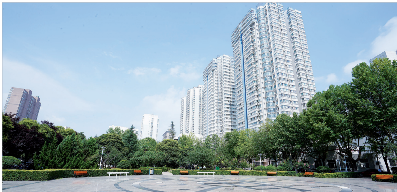
电力苑小区提升改造后新貌
