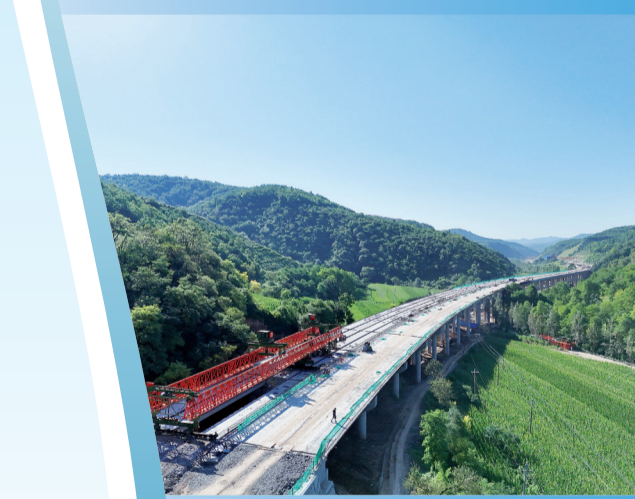
麟法高速公路
