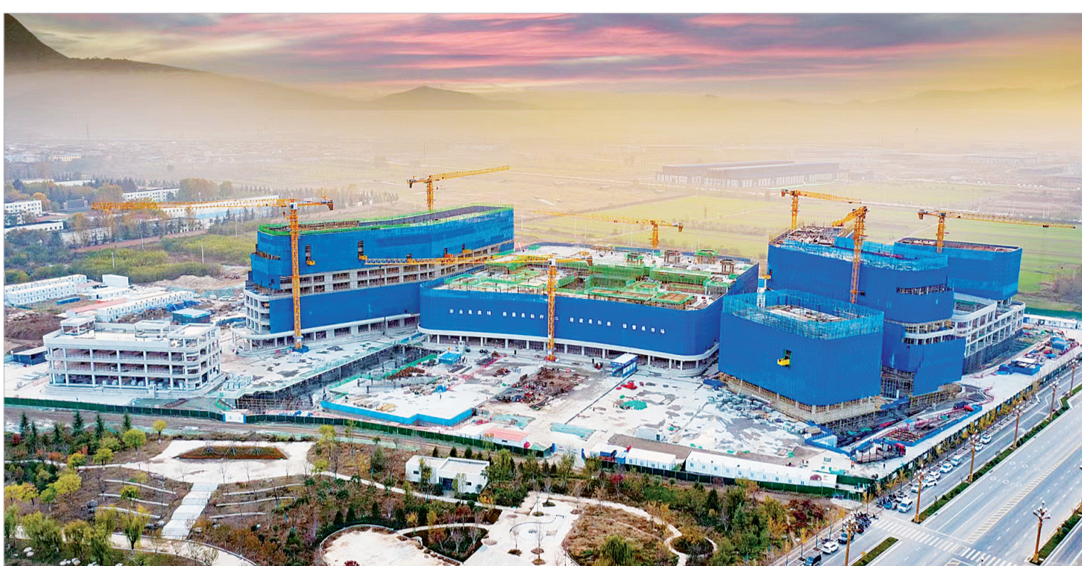
宝鸡市妇幼保健院高新院区项目施工现场
