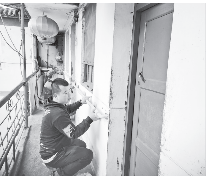
工作人员在楼道里安装扶手
