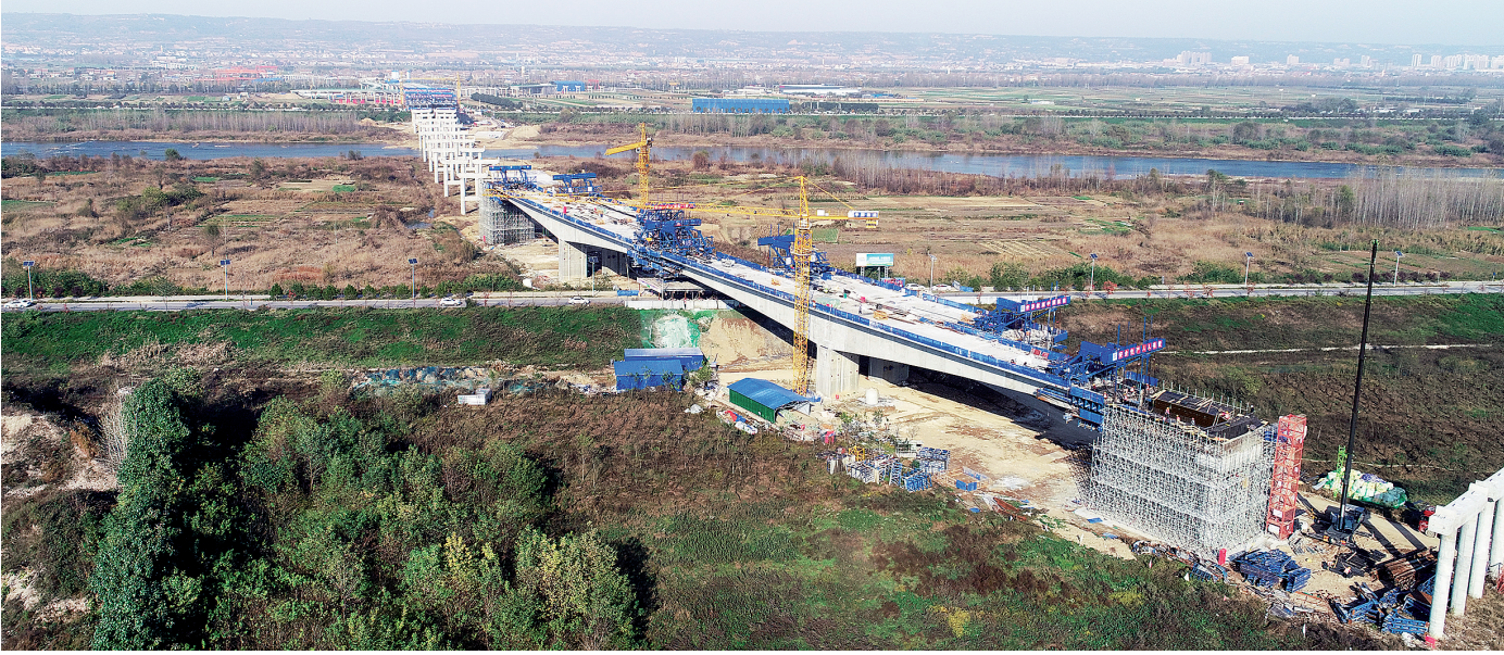
关环高速公路渭河特大桥施工现场
