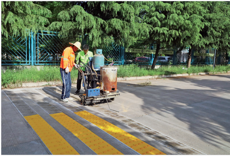
施工人员在平交路口安装减速带
