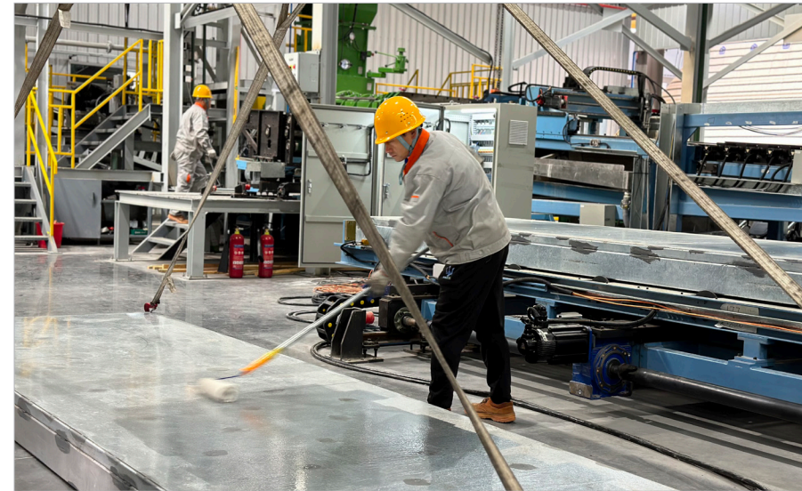
千阳县ECP板材生产线项目,工人正在施工。
