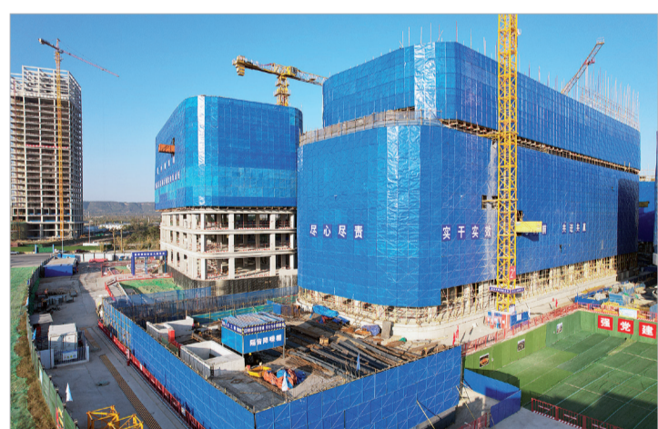
项目建设现场
