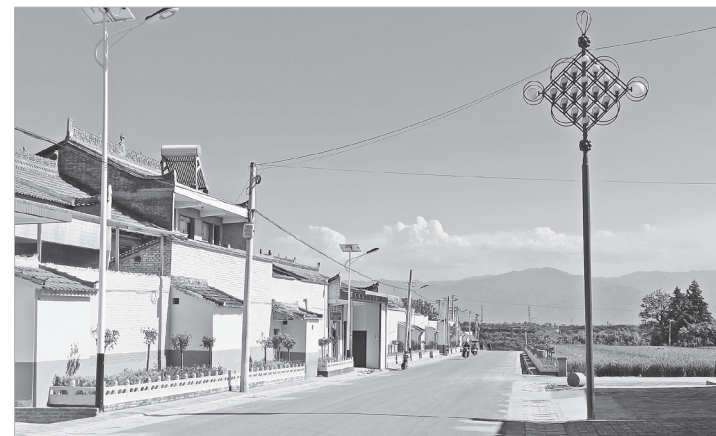
扶风县杏林镇的农村公路
