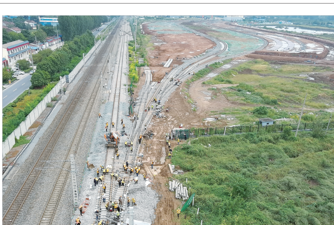
煤炭储运线施工现场
