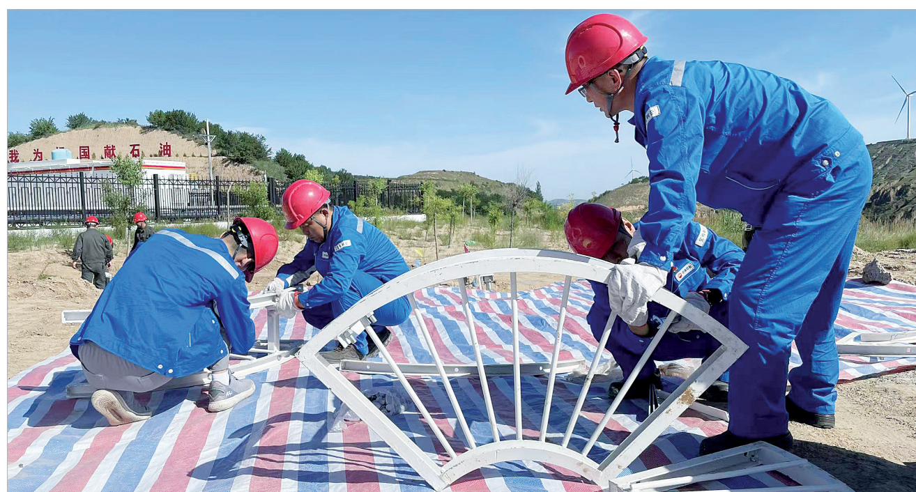
工人在组装垂直轴风力发电机
