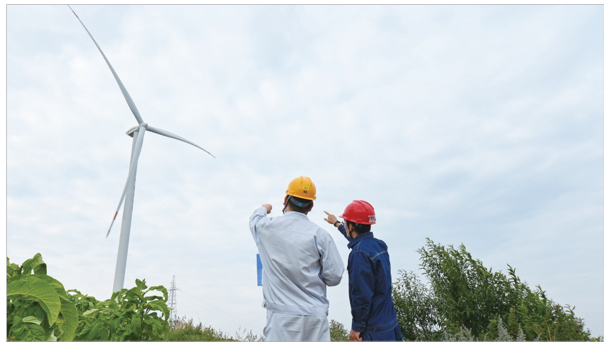
工作人员对风力发电设备做并网前检查
