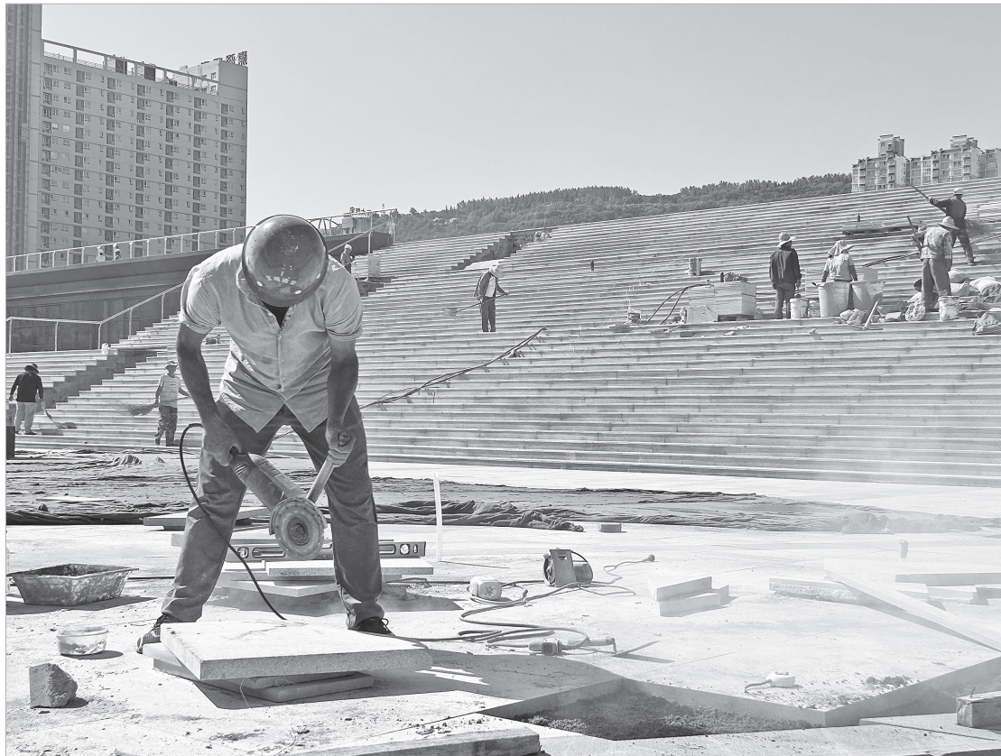
宝鸡火车站广场改造提升项目现场 杨妮摄
