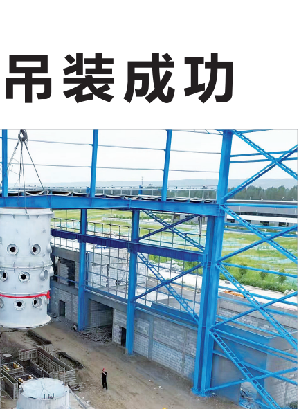
竖炉吊装现场
