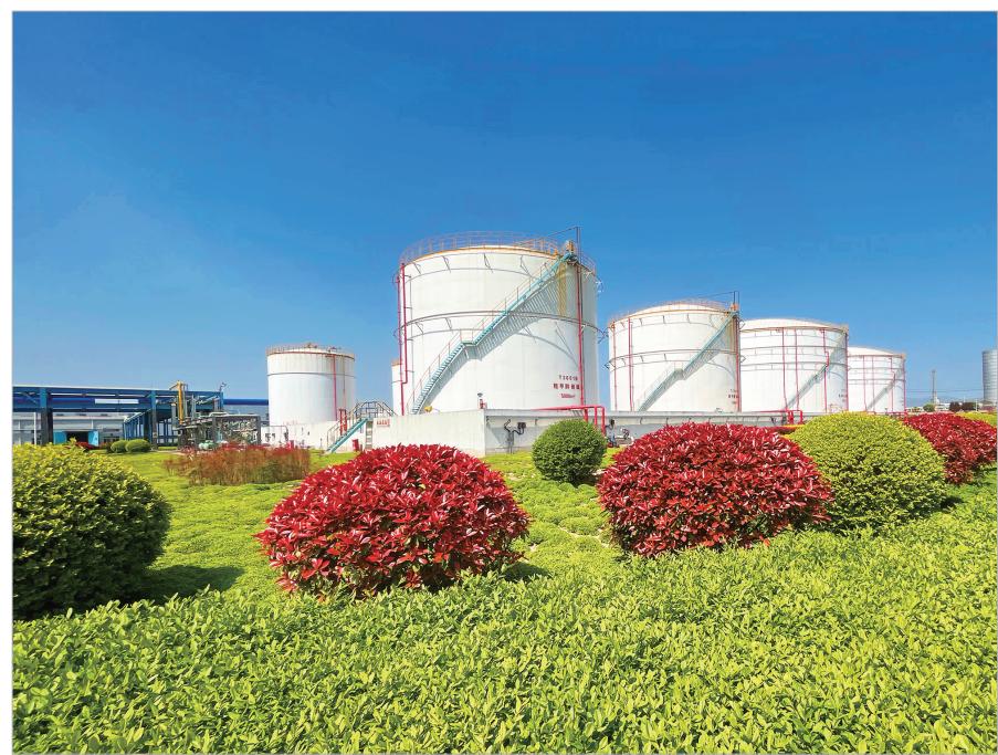
陕西长青能源化工有限公司罐区
