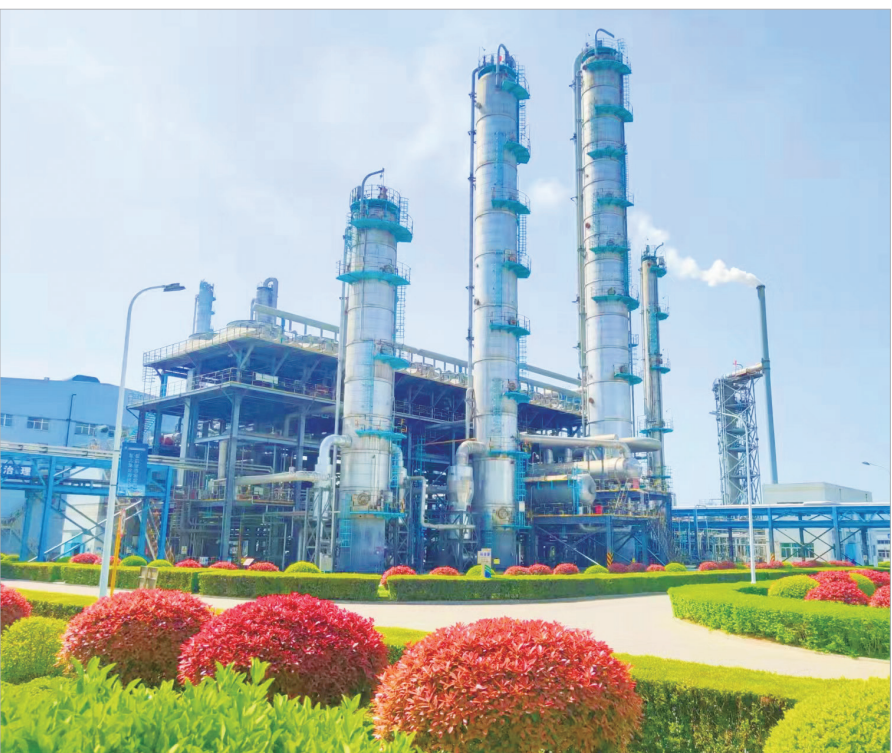
陕西长青能源化工有限公司装置区
