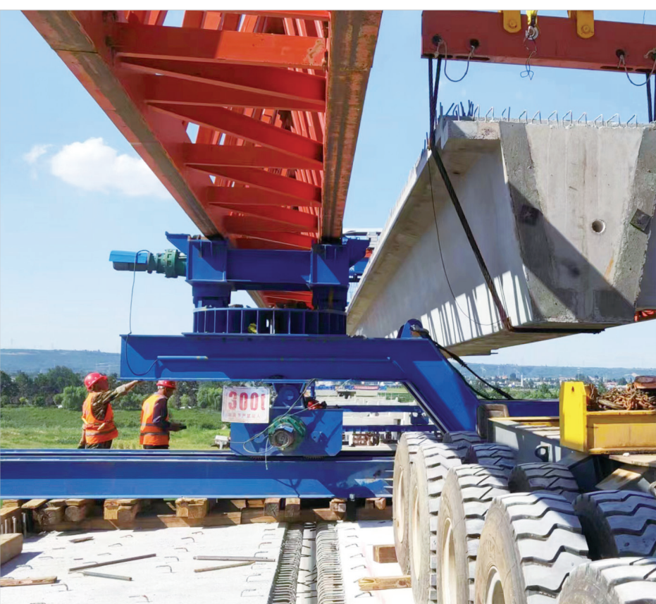
8月13日，一片长50米、重达260余吨的预制箱梁，稳稳架设在眉太高速公路渭河特大桥14号桥墩至13号桥墩之间。据介绍，这片箱梁是我省高速公路首例最长最重箱梁，标志着该项目再次顺利攻克重要节点。（王菁）
