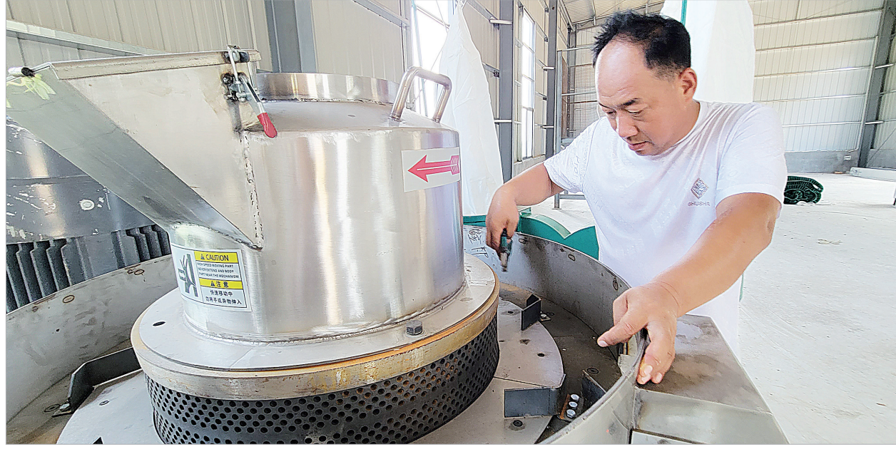
工人在安装设备
