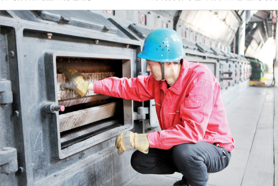
工作人员开展炉排检修工作
