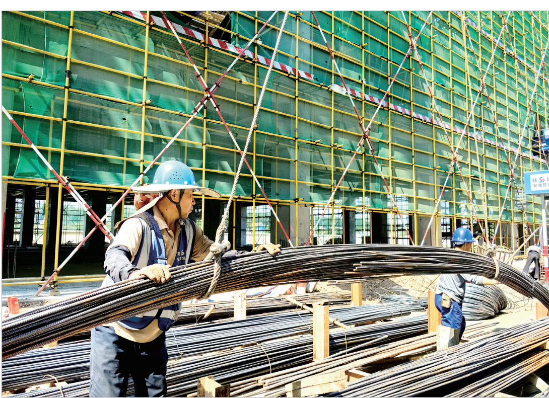
扶风工业园区的标准化厂房及路网配套项目建设现场
