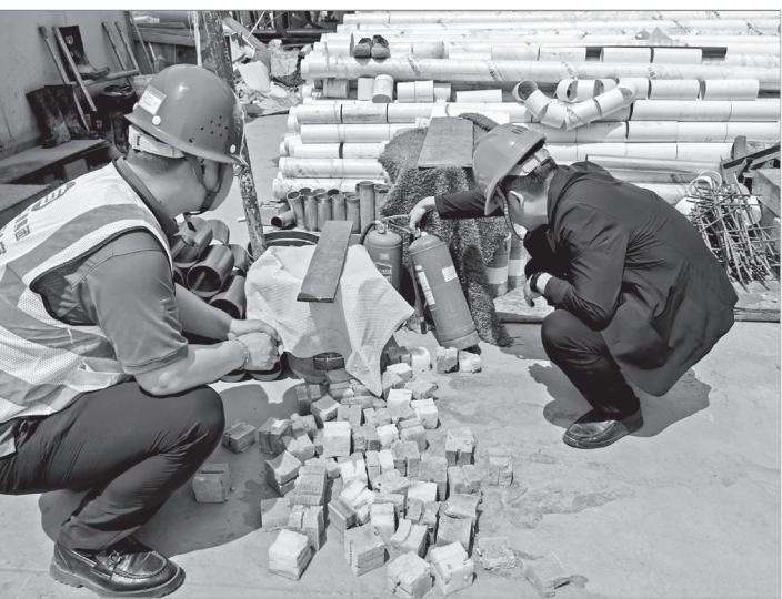
督导组检查建筑工地消防安全
