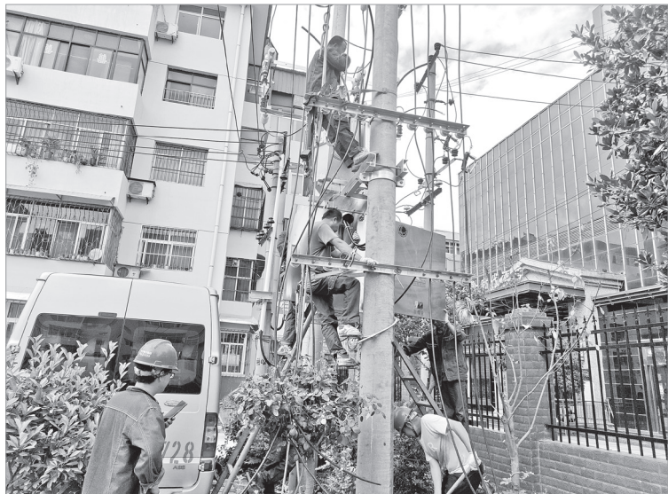
供电部门工作人员更换变压器
