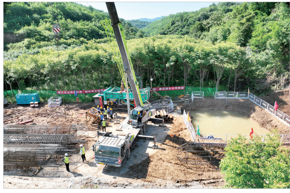
大桥施工现场
