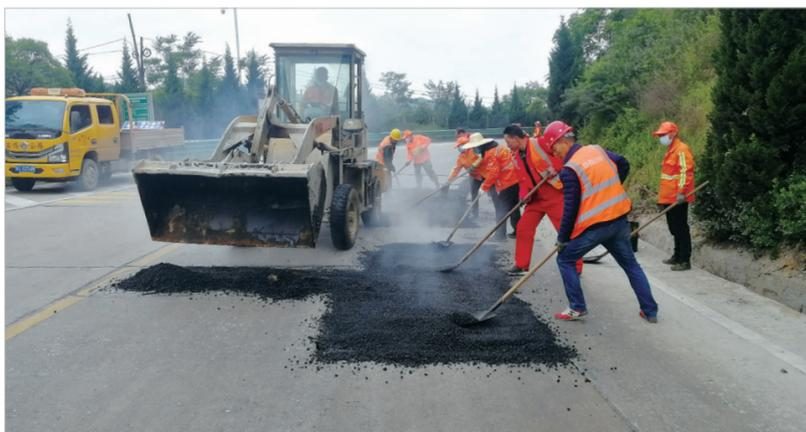
据了解，本次活动在G342线K1568+300—1573+300处开展，太白公路管理段城关、桃川、白云等道班的30余名职工参加。竞赛中，参赛选手在确定病害范围、清尘、计算料铺沥青、摊铺、整平、碾压、灌缝等程序中一展身手（见右图）。大家按照“精、准、细、快”的路面病害处置要求，在施工标志设置、机具准备、人员规范着装、现场安全布控操作等方面进行规范操作。参赛队员在规定时间内严格按照操作程序高质高效地完成了路面病害处置任务，得到了评委组的好评。此次竞赛活动，调动了一线养护职工的工作积极性，提升了养护人员的操作技能，为干线公路预防性养护奠定了扎实基础。
