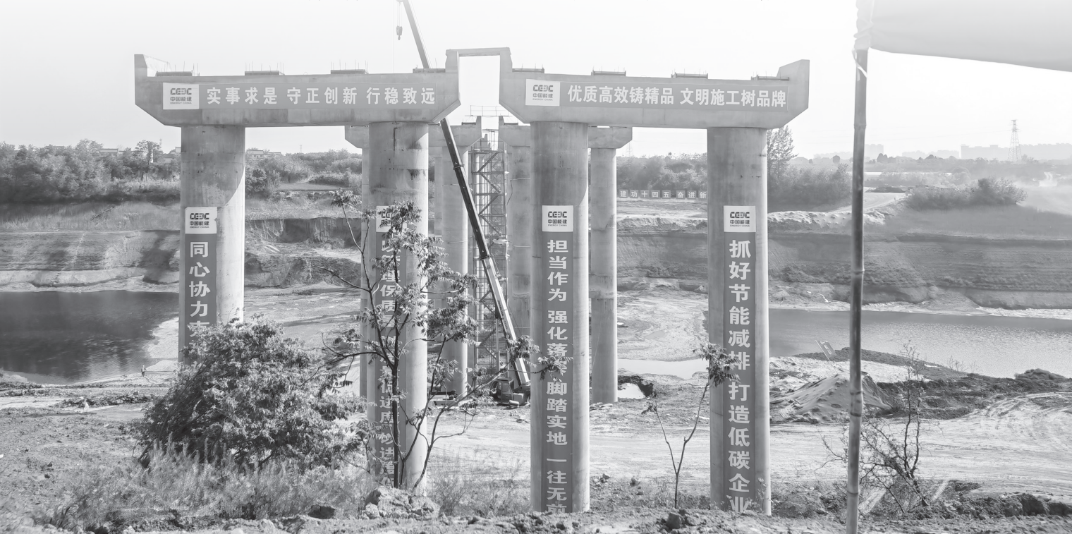
麟法高速信邑水库大桥建设现场
