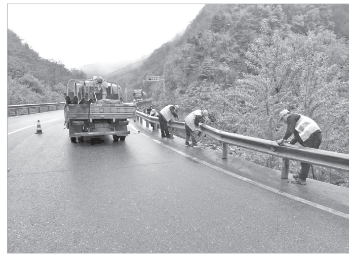
市公路局检查维护道路安全防护设施
