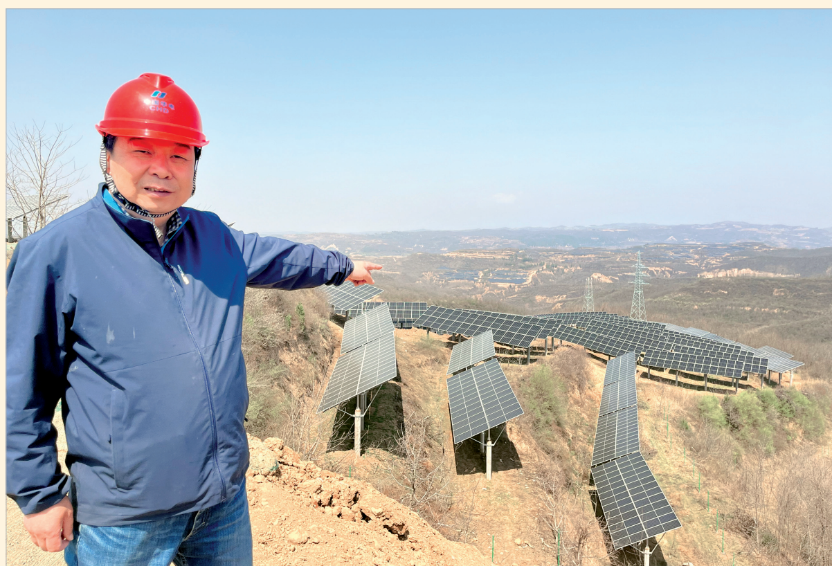
工作人员介绍光伏发电项目建设情况
