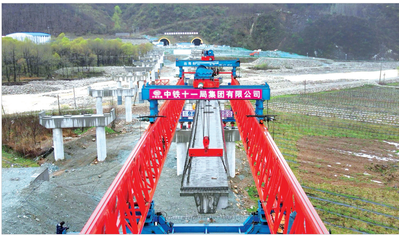
石头河大桥箱梁架设现场（中铁十一局四公司供图）
