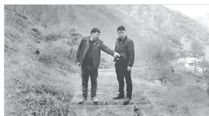
镇村水管人员巡查供水管网
