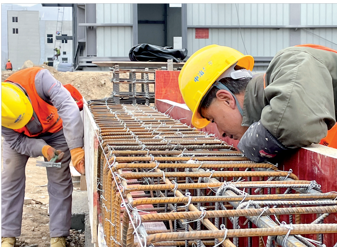
工人加紧施工进度，确保项目如期建成。
