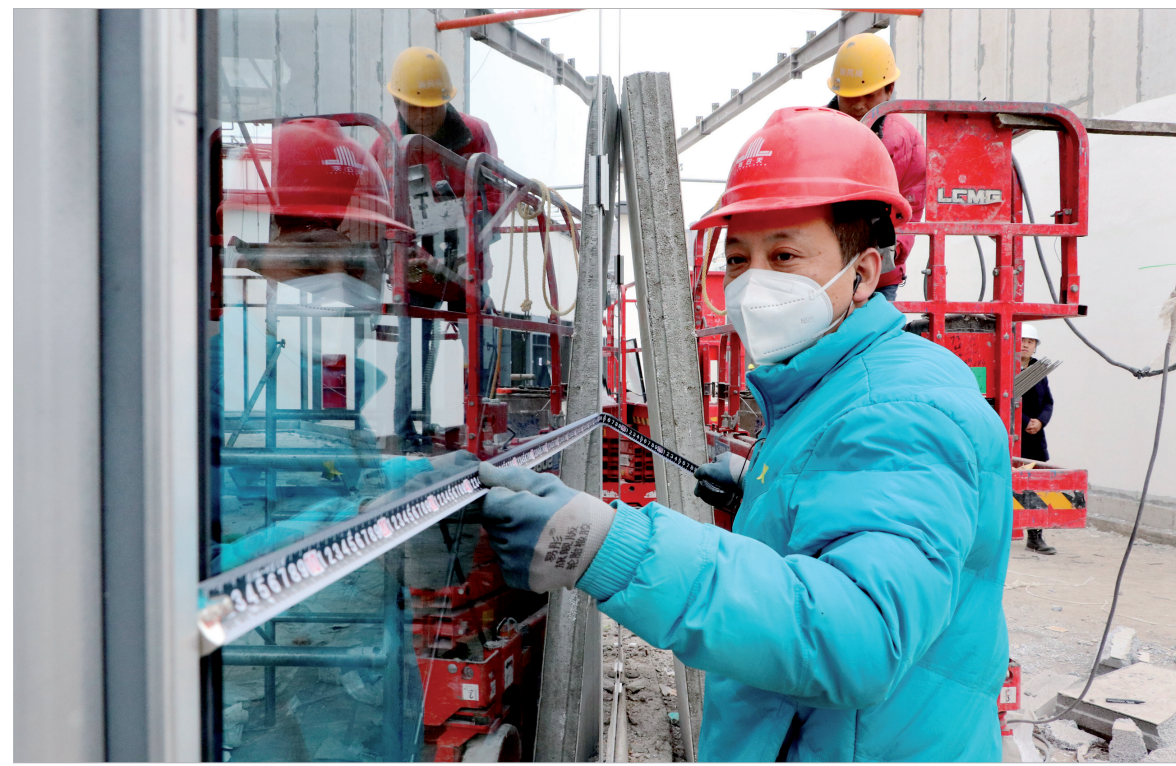
工人正在安装玻璃 石宝军 摄
