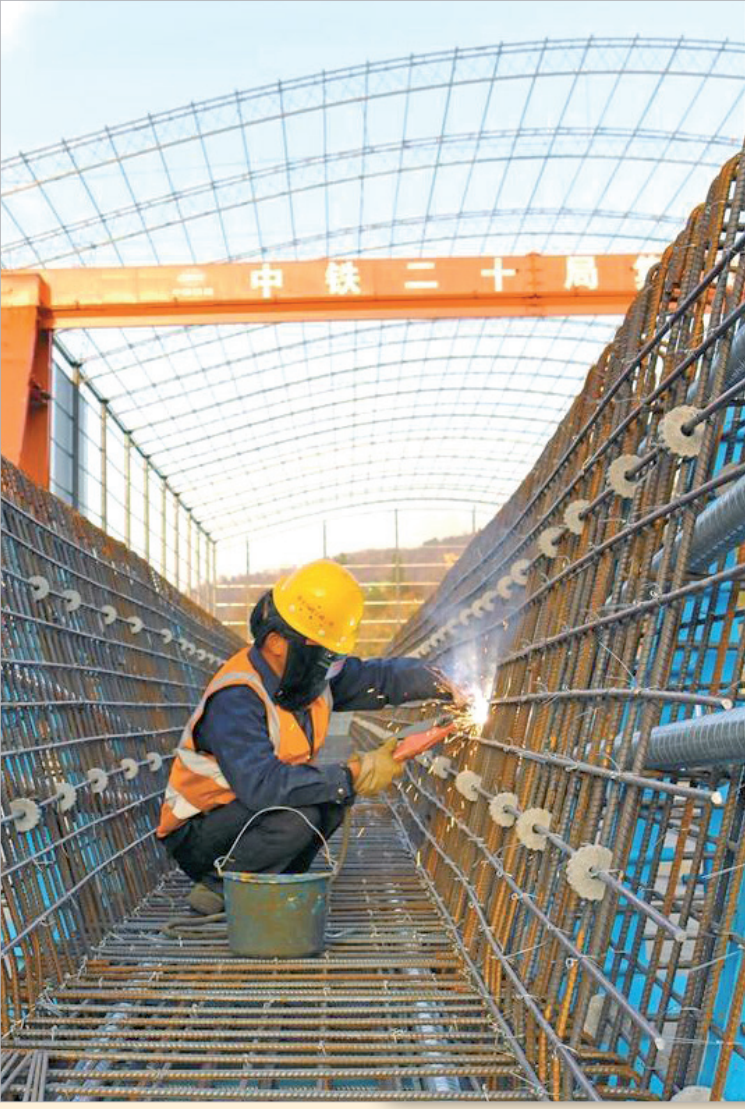
工人正在施工作业
