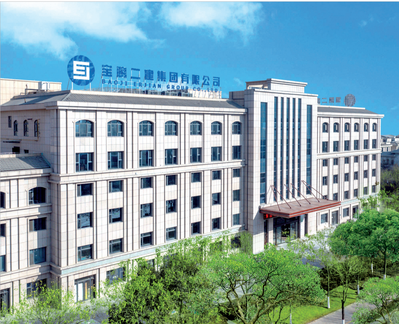
宝鸡二建集团新办公大楼
