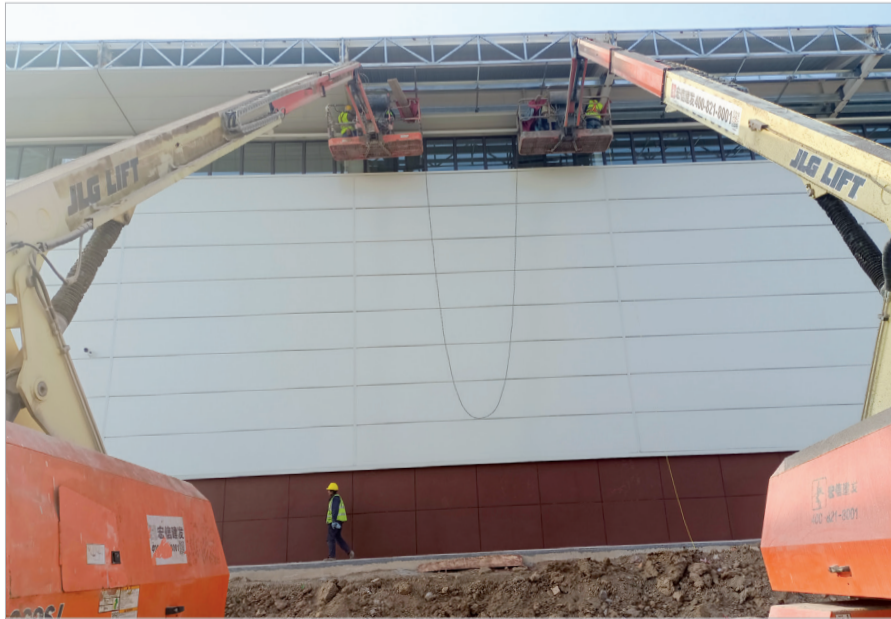
柳林酒业项目建设现场，工人在贴成品酒库的外延板。
