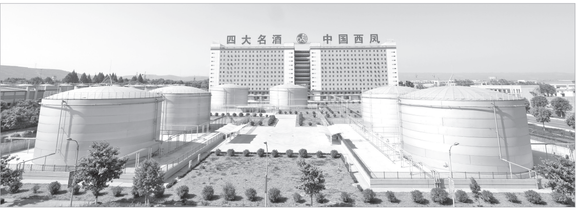
西凤酒现代化万吨制曲大楼
