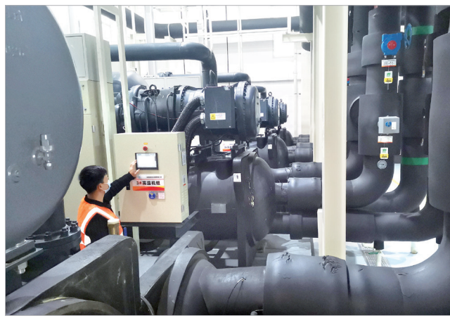
新眉能源的工作人员正在调试设备
