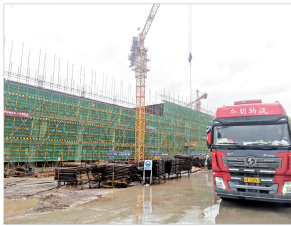
正在建设的西部传感器产业园二期项目
