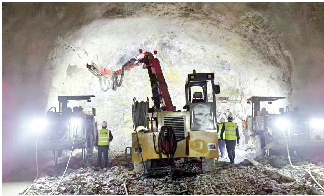
野河山隧道施工现场
