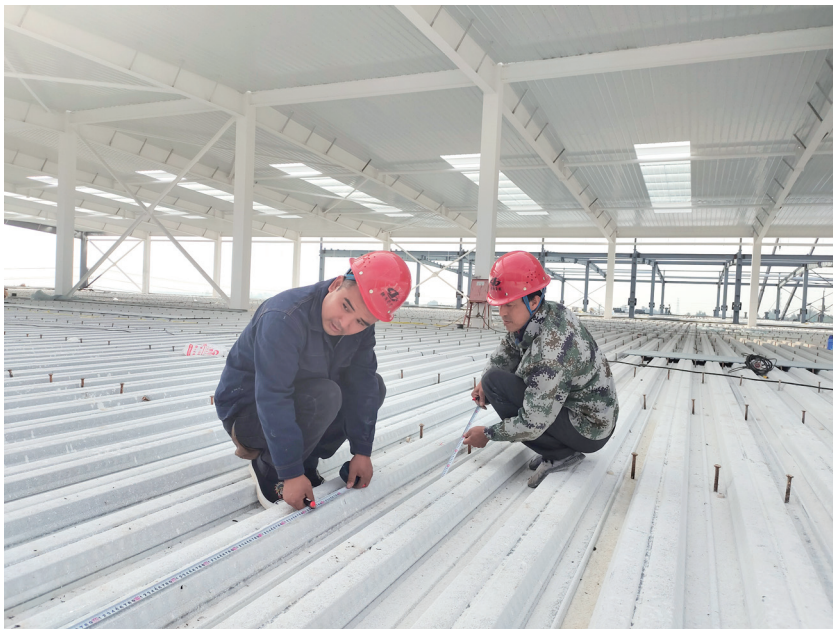
扶风县新兴产业园标准化厂房建设项目施工现场
