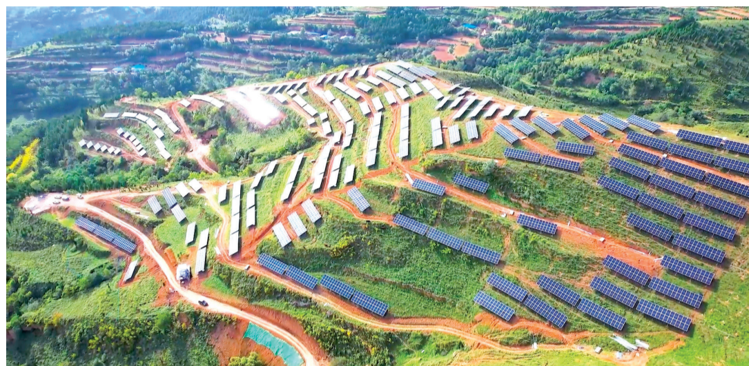
大唐陈仓贾村100兆瓦光伏发电项目
