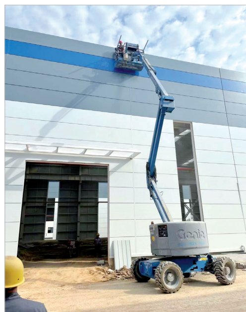
厂房外墙板安装施工
