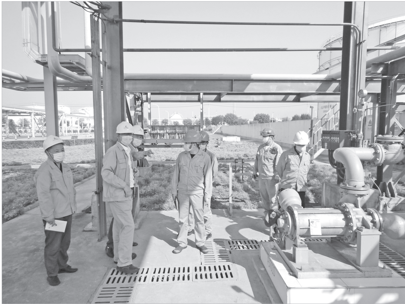
市应急管理局工作人员到重大危险源企业,实地检查安全情况,排除隐患。
