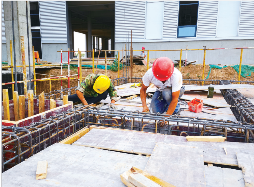
在杂八得日产30万份擀面皮食品产业园项目施工现场,工人在绑扎钢筋。
