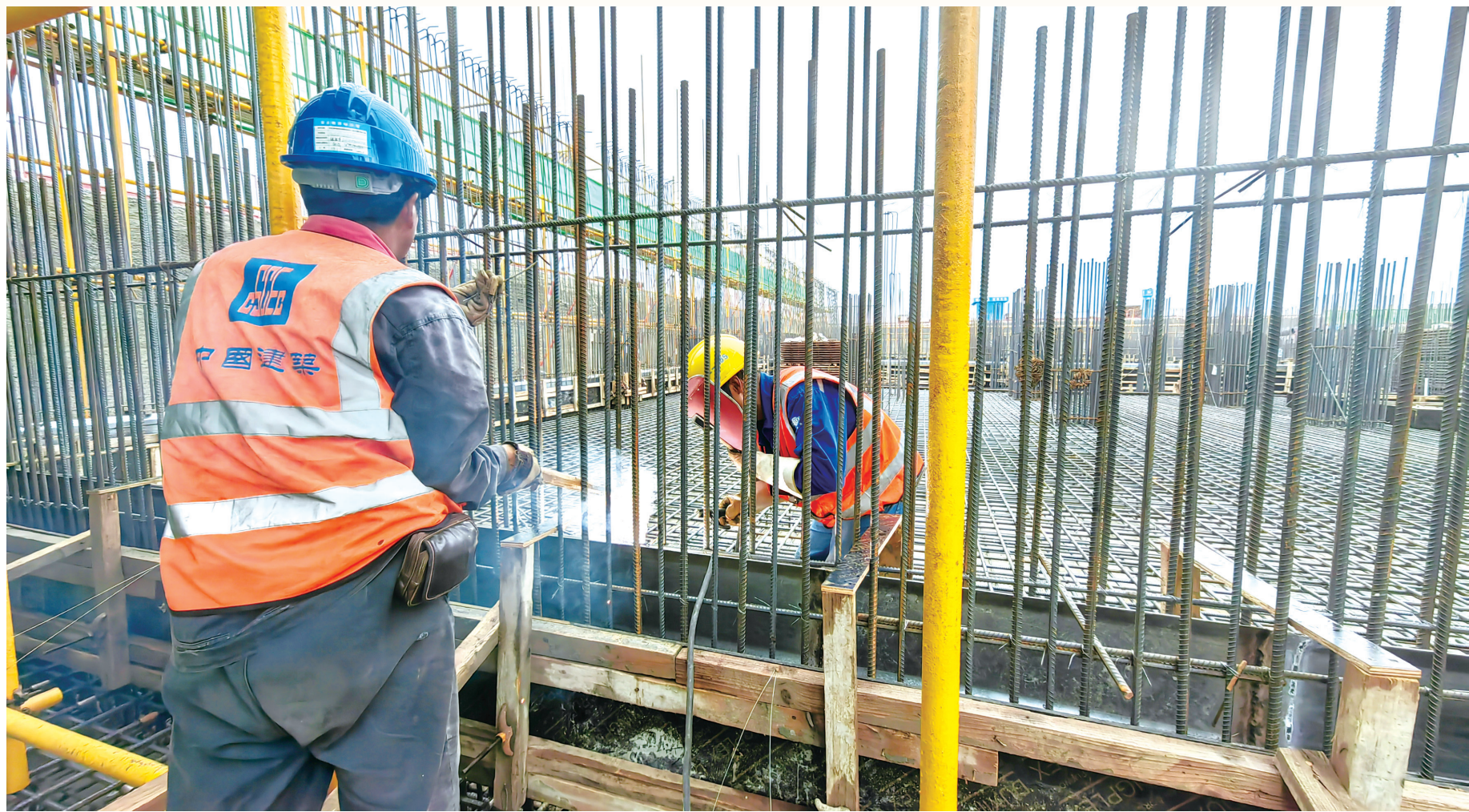
在宝鸡文理学院新校区建设现场,工人加紧施工。
