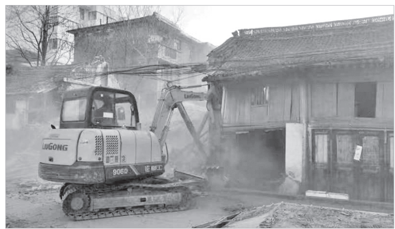
拆除老旧危房
