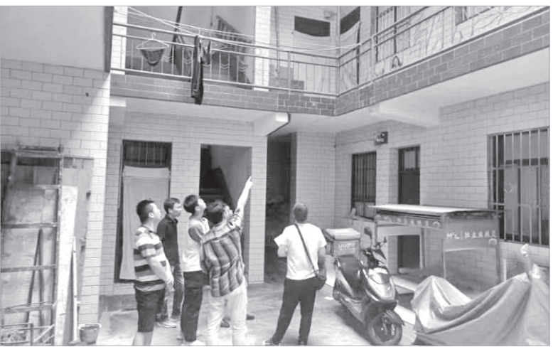
检查房屋外立面
