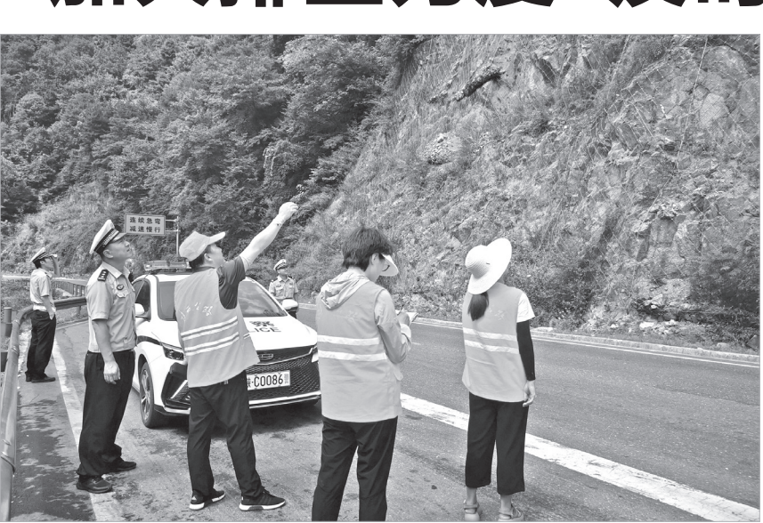
工作人员排查道路隐患
