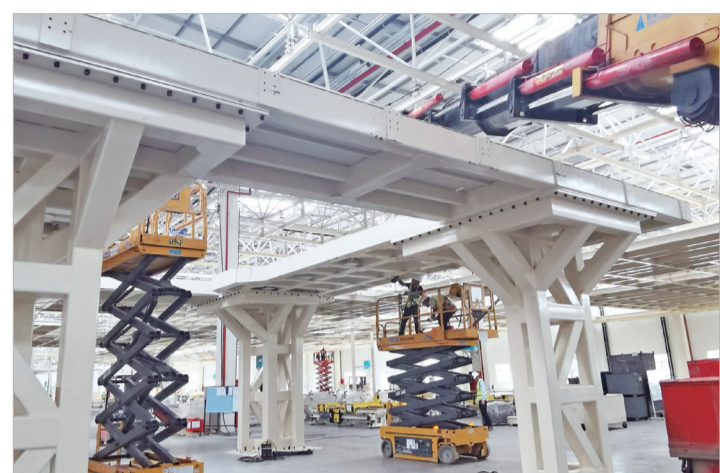
工人在安装总拼平台
